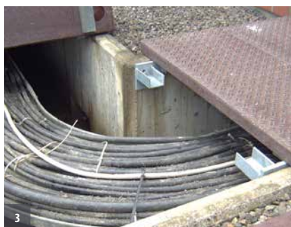
Fixation de deux socles pour un angle de 90°
