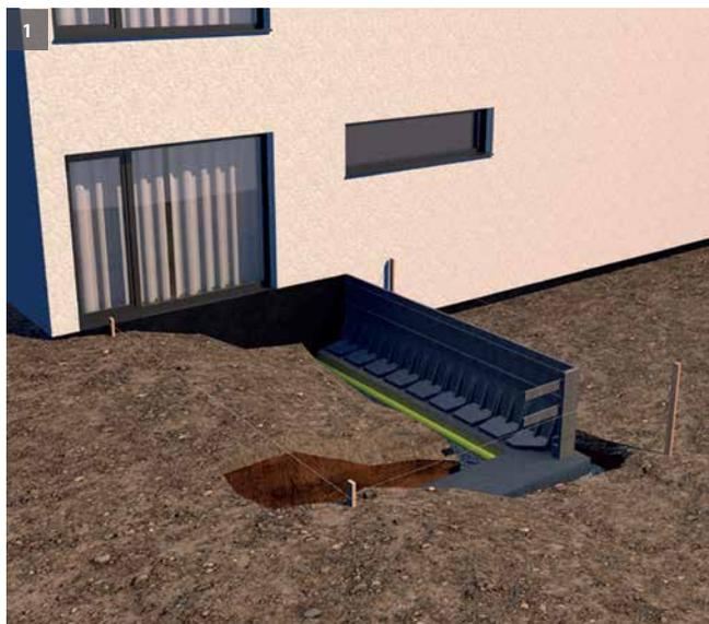
**Étape 1 :** Placez les murs en L sur la fondation en béton durci. En déplaçant les éléments, veillez à ce qu'ils soient bien alignés et installés verticalement.
